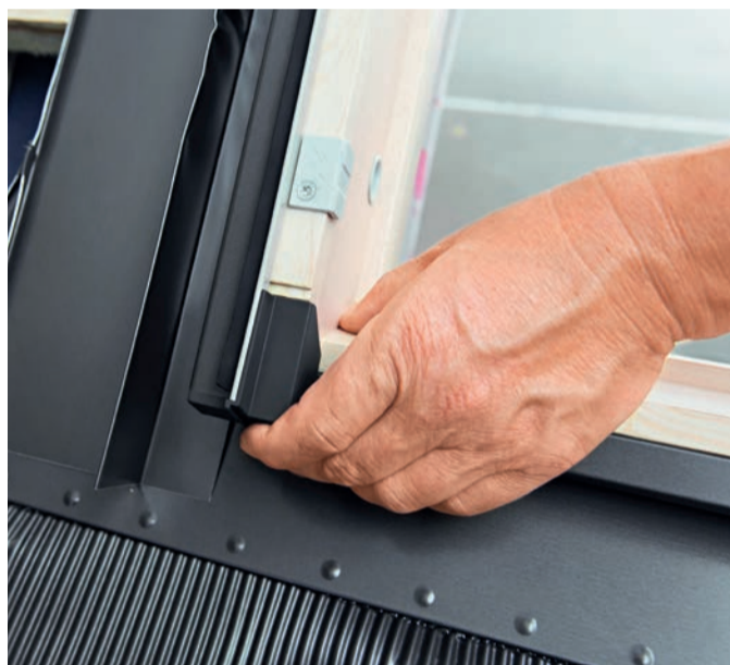
| Posicionar, empurrar, “clique”: todos os elementos do marco coberto indicam por um sinal sonoro quando a montagem foi executada com perfeição.
