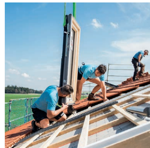
| Os serralheiros tem a janela de telhado Designo R6/R8 Quadro sob controle, pois “Kurt” e “Karl” também auxiliam na montagem: “Kurt” é uma cinta e uma alça de suspensão para guias pré-montadas na fábrica, e “Karl” é uma cinta de transporte recém desenvolvida que combina perfeitamente com a ferramenta.
