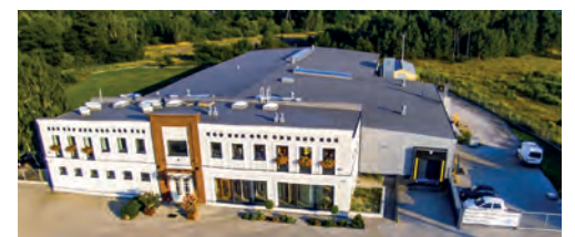
Edward Skal e sua filha Iwona tiveram apenas 5 meses em 2012 para construir uma nova planta, após estar claro que as plantas de produção atuais tinham de ser retiradas para uma grande obra de rodovia. Atualmente trabalham cerca de 20 funcionários especializados na moderna fábrica da cidade polonesa de Łódź.
