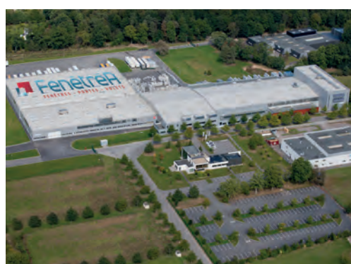
Na empresa FenêtréA na cidade francesa de Beignon, próxima à cidade de Rennes, no noroeste da França, são produzidas cerca de 220.000 janelas e portas em PVC e 50.000 itens em alumínio anualmente.
