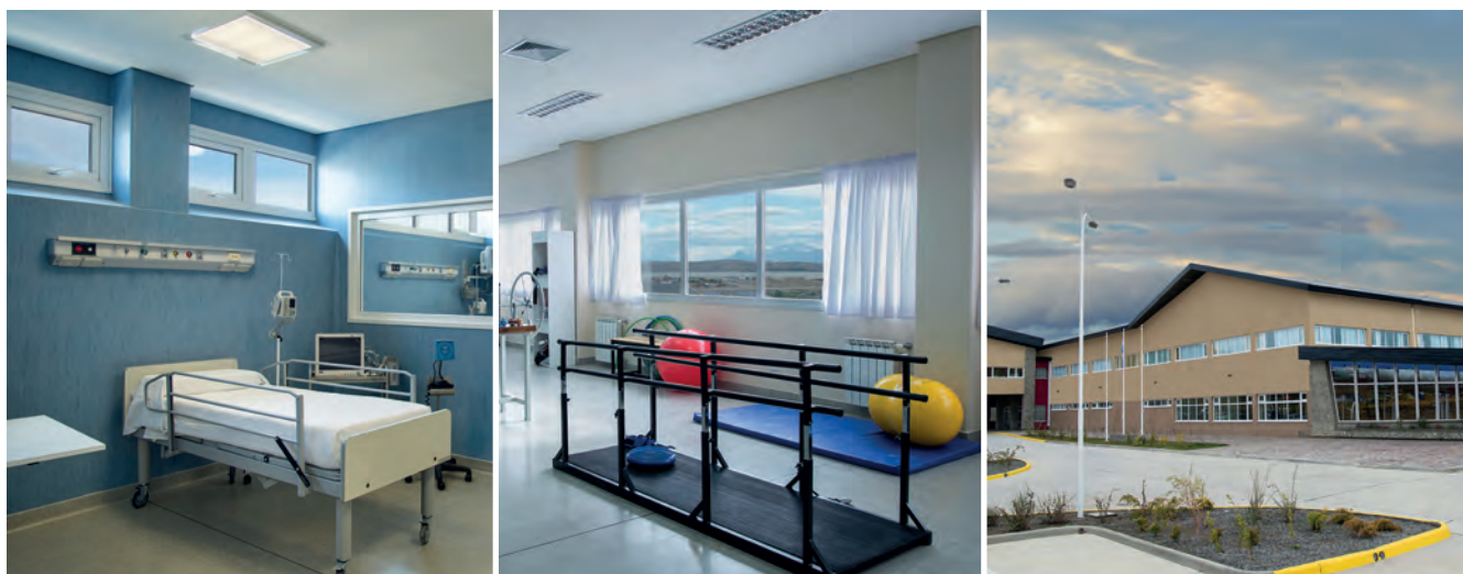
Na província Santa Cruz na Argentina, foi construído o novo hospital de El Calafate. O Grupo MLP SRL forneceu as janelas oscilobatentes Ventex equipadas com ferragens Roto NT.
