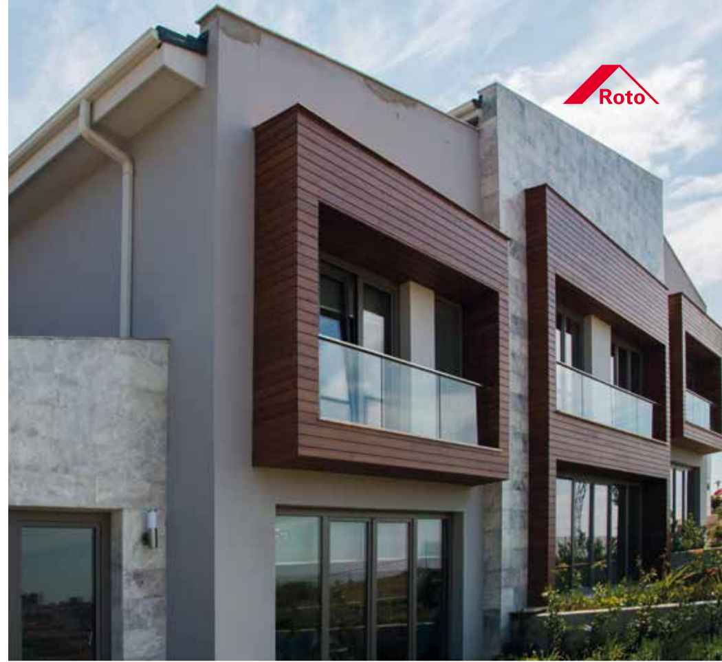
| Asmalı Bahçe Şehir – um novo quarteirão na zona de Istambul chamada de Büyükkçekmece
