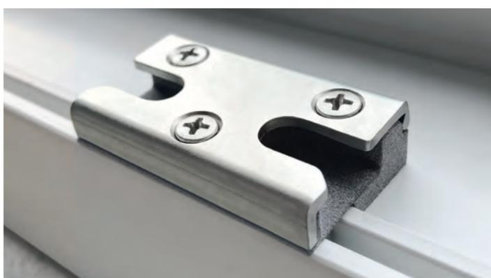
Peça de fechamento em aço do caixilho com suporte em PVC impresso em 3D para aplicação em uma janela com compatibilidade RC 3
