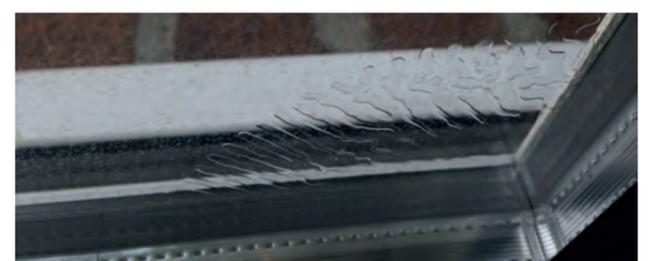
Como consequência de uma reação química na compatibilidade material, a película de união solta-se.
