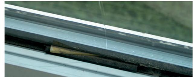
Origem dos erros: O calço posicionado na diagonal leva a fissuras no vidro.
